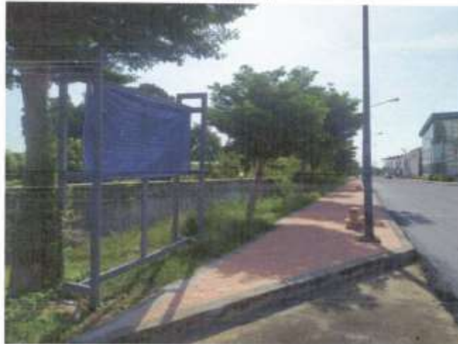
ภาพถ่ายป้ายประชาสัมพันธ์โครงการปรับปรุงถนนแอสฟัลต์ติกคอนกรีตพร้อมปรับปรุงทางเท้า ถนนทางเข้าศูนย์วิทยาศาสตร์ ค่ายบยานชี้อำเภอเมืองอ่างทอง จังหวัดอ่างทอง บริเวณจุดที่ ๒ จุดสิ้นสุดโครงการฯ
